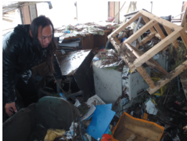
津波で被災した管理棟
